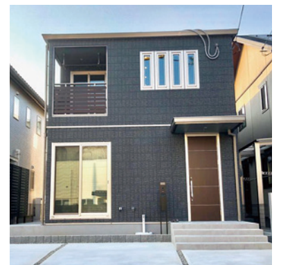
★実際の建物を撮影した写真です。(2020年5月1日撮影)
