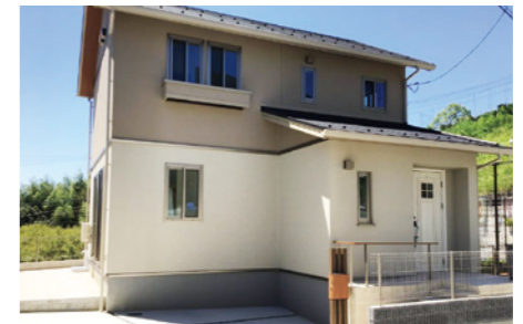
★実際の建物を撮影した写真です。(2020年8月21日撮影)
