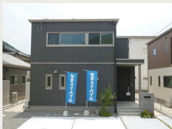
※2号地外観写真 2020年6月22日撮影
