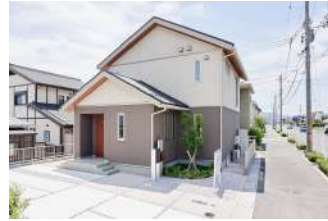
1号地外観(2021年6月撮影)
