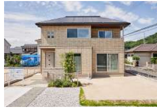
8号地外観(2021年6月撮影)
