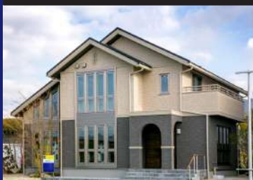
サエラツユー展示場
