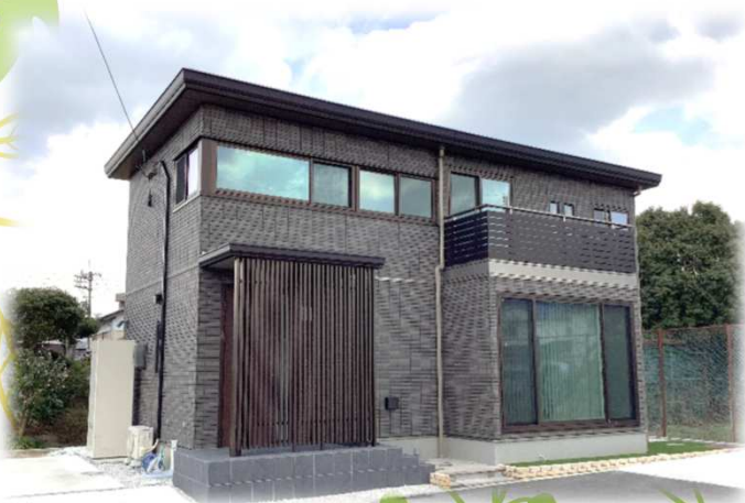
外観写真 (2023年1月撮影)
