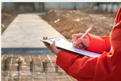
敷地調査/土地探し
